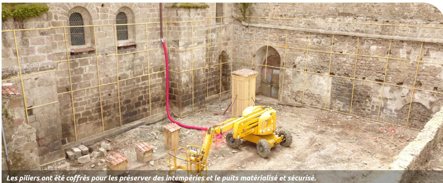
Les piliers ont été coffrés pour les préserver des intempéries et le puits matérialisé et sécurisé.
