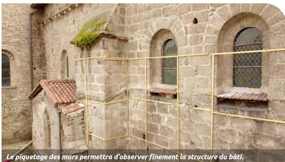
Le piquetage des murs permettra d'observer finement la structure du bâti.
