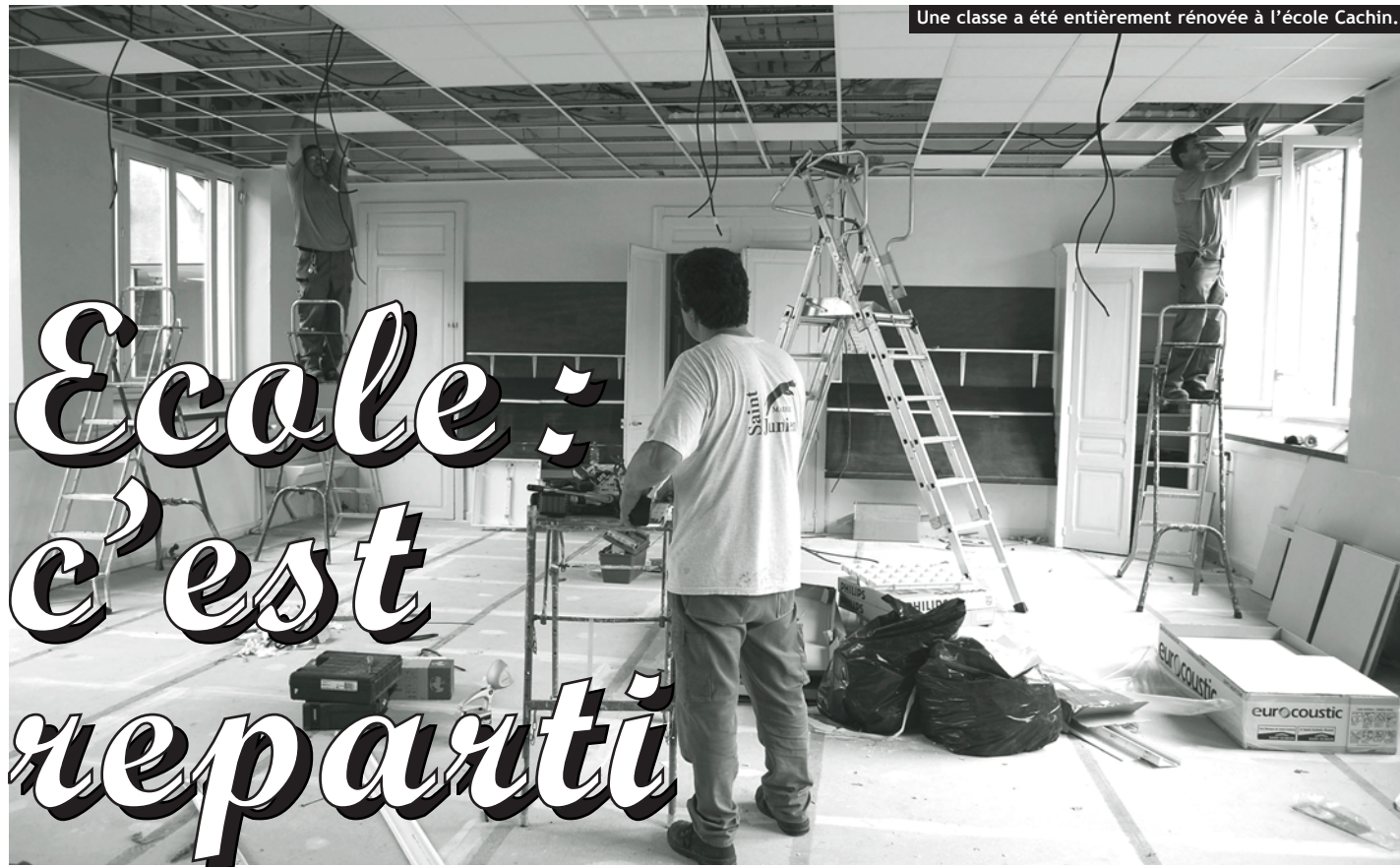
Une classe a été entièrement rénovée à l'école Cachin.
