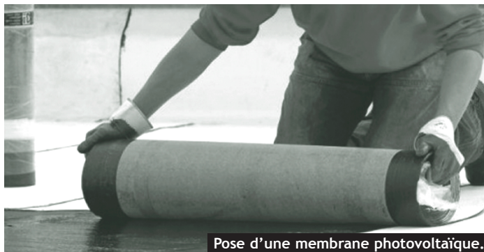
Pose d'une membrane photovoltaïque.
