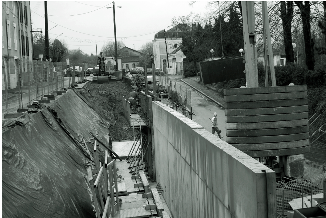
Un an après. Le mur s'est effondré en décembre 2010. Il aura fallu attendre les expertises, le travail des assureurs, les études techniques, le montage du dossier en collaboration avec l'architecte des Bâtiments de France pour pouvoir lancer, en juin dernier, la consultation des entreprises. Le marché a été attribué mi-octobre et l'ordre de service délivré fin novembre.
