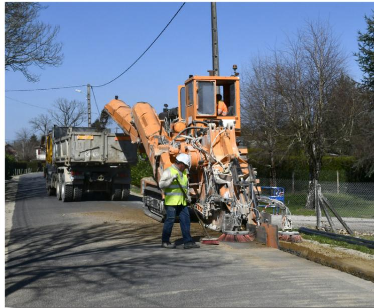
Des travaux sur le réseau d'alimentation en eau potable sont en cours route des Charles. La première tranche concerne le remplacement de près d'un kilomètre d'un réseau vieux d'une quarantaine d'années et sur lequel les fuites étaient nombreuses. L'originalité du chantier tient à l'utilisation d'une trancheuse, une première sur la commune. Cette technique, en tranchée étroite, permet un gain de temps et une légère économie financière. La seconde tranche consiste à rem-
