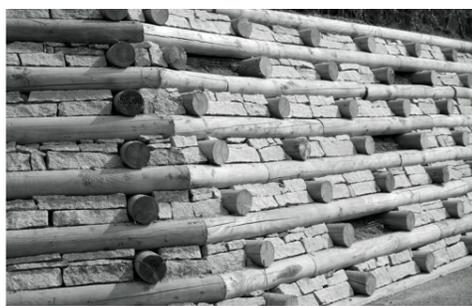
Un mur de soutènement a dû être monté chemin des Gouttes à hauteur de la gendarmerie. La municipalité a fait le choix de le bâtir en structure bois dans une démarche de développement durable.
