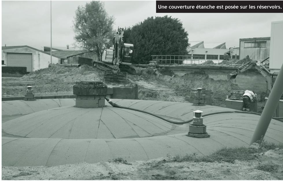
Une couverture étanche est posée sur les réservoirs.
